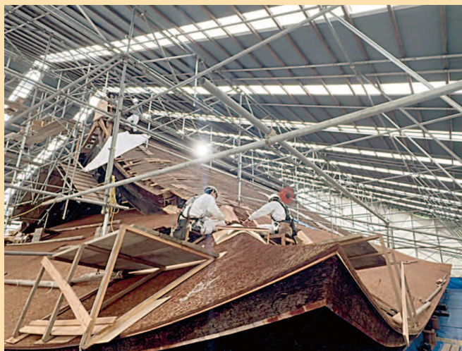
善水寺の檜皮屋根葺き替えの工事（13ページ掲載）
