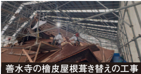
善水寺の檜皮屋根葺き替えの工事
